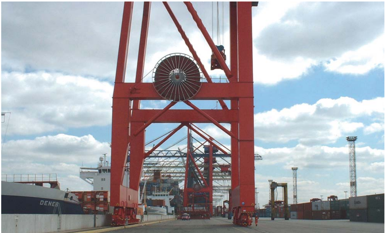
Enrollador de cable a motor LT 25/72 H4K 240/LWL-18/FPGL en una Grúa de contenedores en el puerto de Hamburgo con cable de 10 kV. Accionamiento mediante motor con rotor en cortocircuito y variador de frecuencia.
