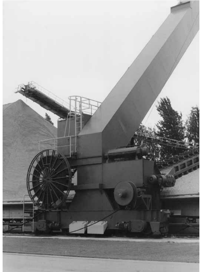
Enrollador de cable a motor con cables redondos en un Decantador.
