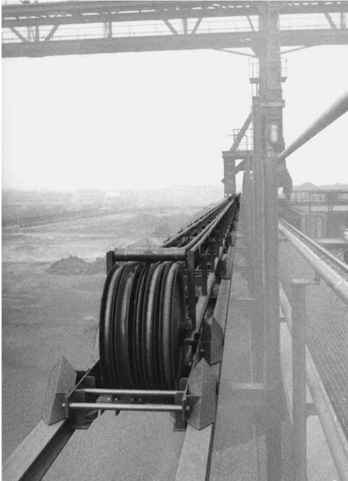
Sistema tender con cables redondos en una instalación minera.
