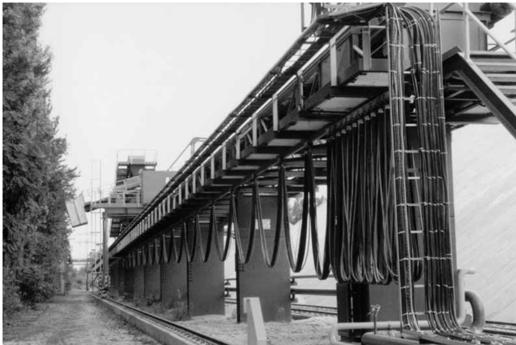
Instalación de Carros portacables con cables planos en una Cinta transportadora
